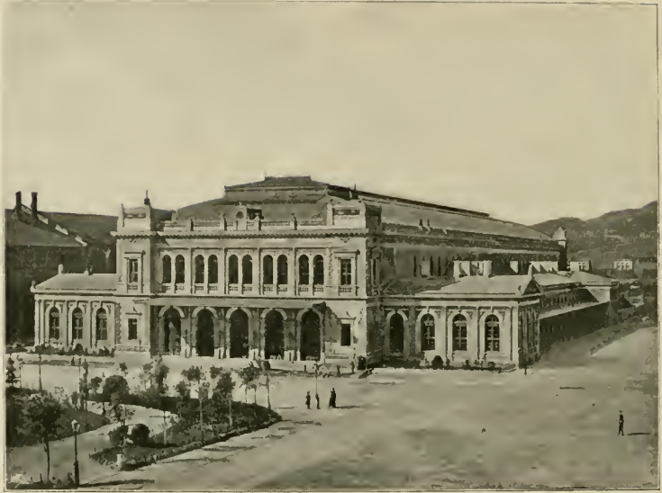
Abb. 274. Aufnahmegebäude der Südbahn in Triest. [1883.]
